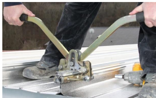
Abbildung 5: Vorfalzen mit der Falzzange
