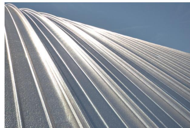
❖ Die durchdringungsfreie Montage der Stehfalzbahnen sorgt für ein langlebiges und sicheres Dach Ihrer Tennishalle.
