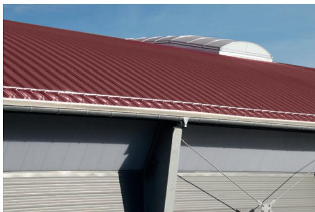
❖ Tennishalle Künzelsau – die Stehfalzbahnen in „Hockeystick-Form“ lassen das Dach und die Fassade zu einer Einheit werden.
