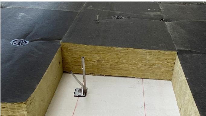
Dämmung anbringen. Dämmung im Bereich der Konsolen einschneiden und mit Dämmstoffdübeln gemäß DIN 18516 befestigen. Eine lückenlose Montage ist zwingend zu berücksichtigen um den Wärmeschutz durchgängig zu gewährleisten. Sollten Brandsperren aus TEKOFIX A++ zur Ausführung kommen, dann ist dies separat abzustimmen.
