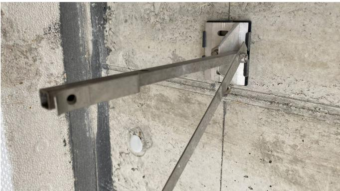
TEKOFIX A++ Konsolen gemäß den Vorgaben des Verlegeplans montieren und mit den Verankerungsmitteln nach Statik befestigen. Durch das Langloch in der Basiskonsole kann die Konsole noch justiert werden. Dabei auf unterschiedliche Gleit- und Festpunkte achten.
