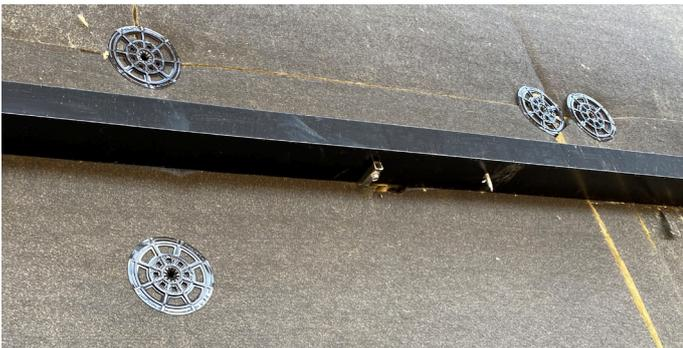
Vollständig ausgerichtete und mittels Bohrschraube montierte Tragprofile zur Aufnahme der vertikalen Fassadenbekleidung. **Hinweis:** Die Hinterlüftung der Fassadenbekleidung ist projektweise und im Einzelfall zu prüfen.
