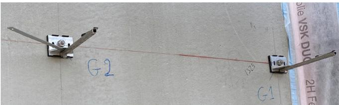
TEKOFIX A++ Konsolen gemäß den Vorgaben des Verlegeplans montieren und mit den Verankerungsmitteln nach Statik befestigen. Durch das Langloch in der Basiskonsole kann die Konsole noch justiert werden. Dabei auf unterschiedliche Gleit- und Festpunkte achten.
