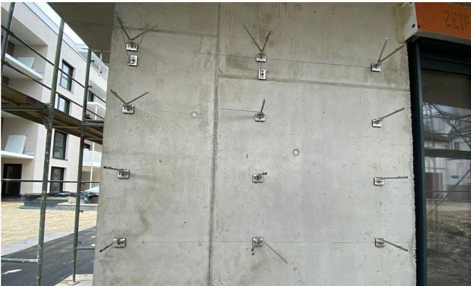
Mit TEKOFIX A++ fertig montierte Wandfläche. Die horizontale Aussteifung der Unterkonstruktion findet durch die seitliche, schräg verlaufende Zugstrebe statt.
