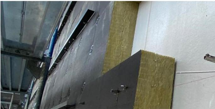
Die Tragprofile ausrichten und mittels Bohrschraube befestigen. Dabei das Längenausdehnungskonzept der Planung beachten. Auf die fertig montierte Unterkonstruktion kann nun die Fassadenbekleidung angebracht werden.
