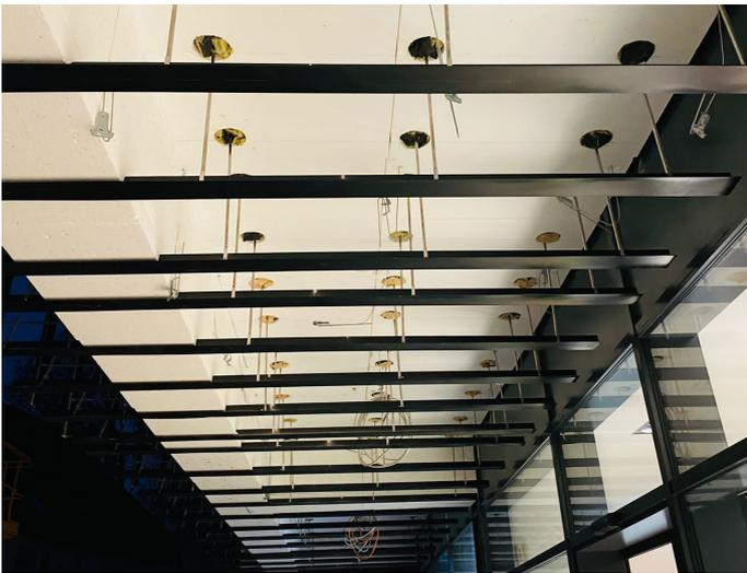
TEKOFIX A++ kann auch zur Abhängung von Decken verwendet werden. Hierbei sind Abhängehöhen von 100 - 750 mm möglich. Sowohl für Neubauten als auch für Sanierungen mit Bestandsdämmung realisierbar.
