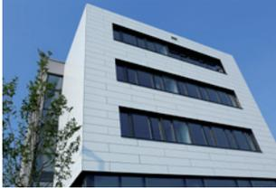
BEMO-BOND Fassadenverbundplatten werden hauptsächlich als Bekleidung von vorgehängten hinterlüfteten Fassaden (VHF) verwendet.
