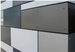
Die Sichtseite ist mit einer der weltweit hochwertigsten Beschichtungen lackiert, die der Oberfläche von Teflon sehr ähnlich ist – BEMO-FLON.
