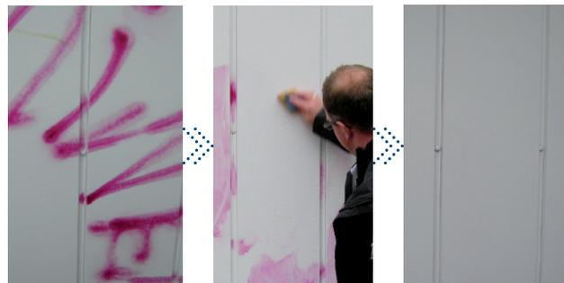
*Unerwünschtes Graffiti kann mit einem speziellen Reiniger dank BEMO-FLON Beschichtung einfach abgewaschen werden.*
